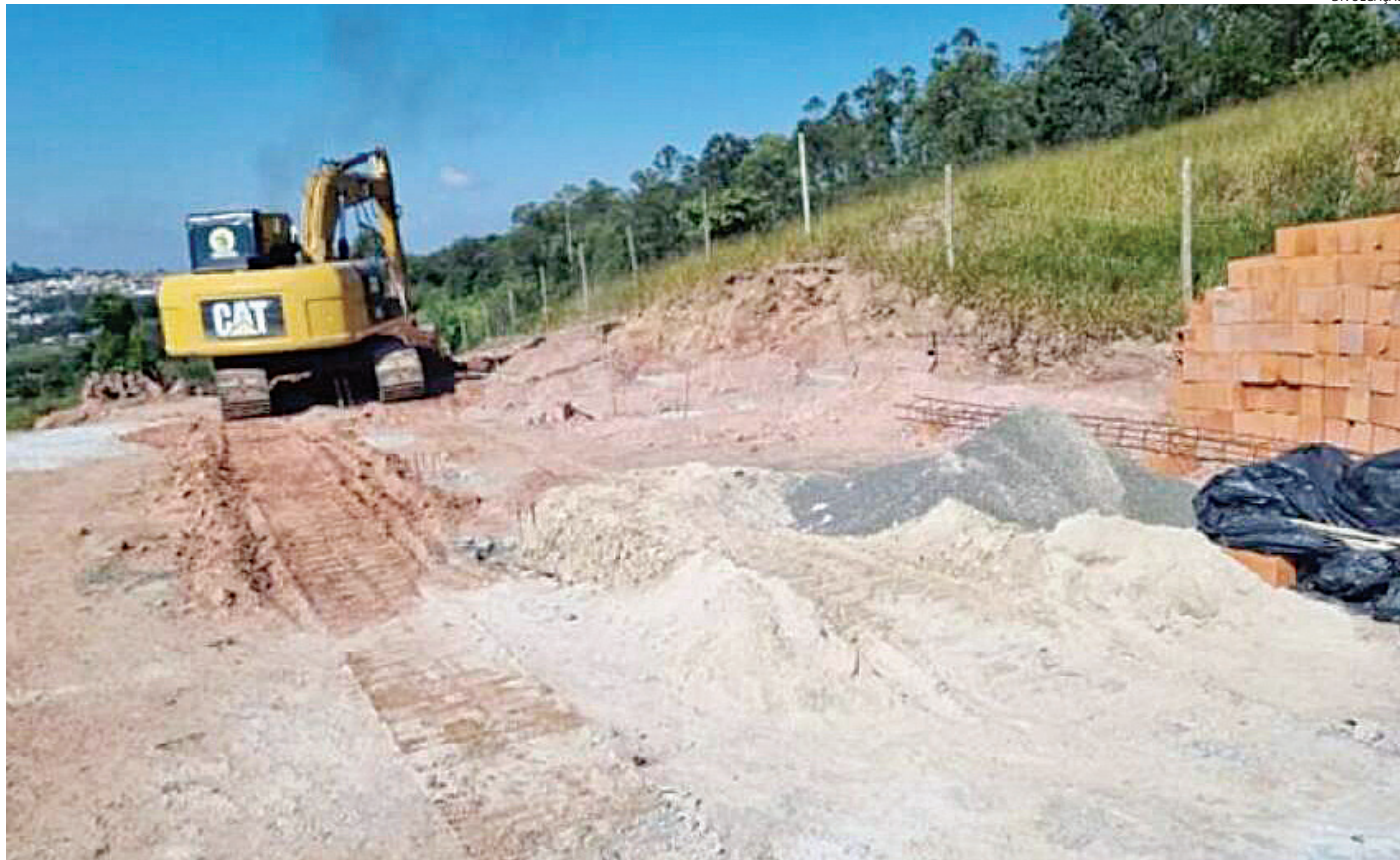
Neste ano, um loteamento irregular foi desmontado no bairro Pinheirinho, em Jundiaí e mais quatro foram identificados
