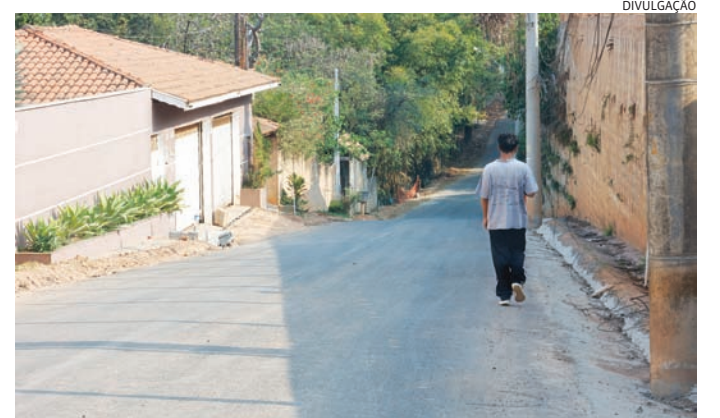
No Bom Jardim, o asfalto ecológico já traz mais conforto e segurança
