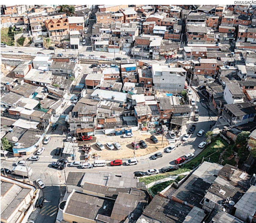
A área de intervenção está localizada entre as ruas Pedro Latance e Benedito Basílio
