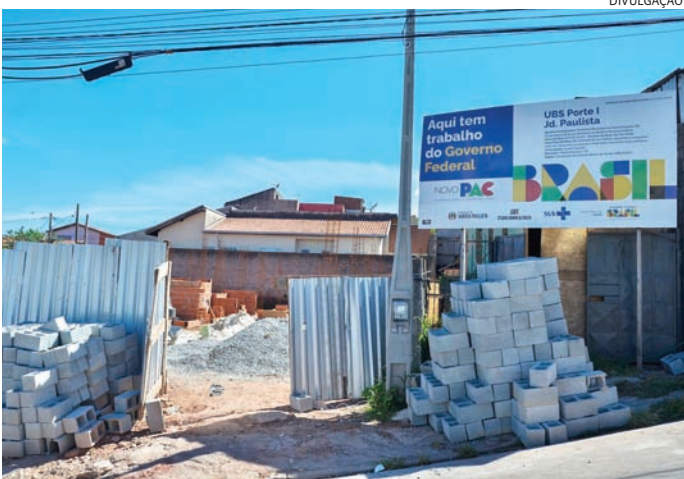
Equipamento está localizado entre as ruas Porto Feliz e Jundiaí
