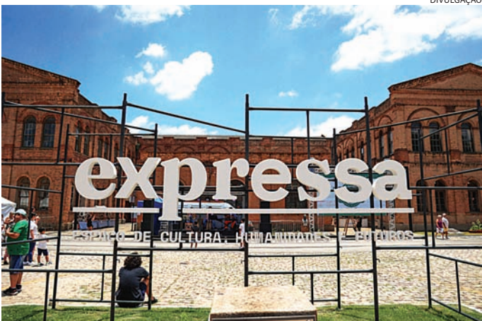
Telhado do estacionamento do Expressa custou R$ 59 mil
