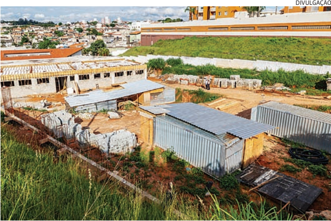
A ampliação e reforma da UBS Tamoió está com 32% de conclusão
