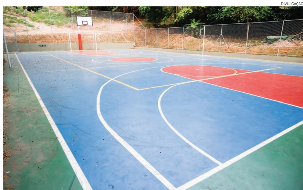
Espaço está com mais de 95% da obra concluída, restando apenas parte da jardinagem para ser complementada
