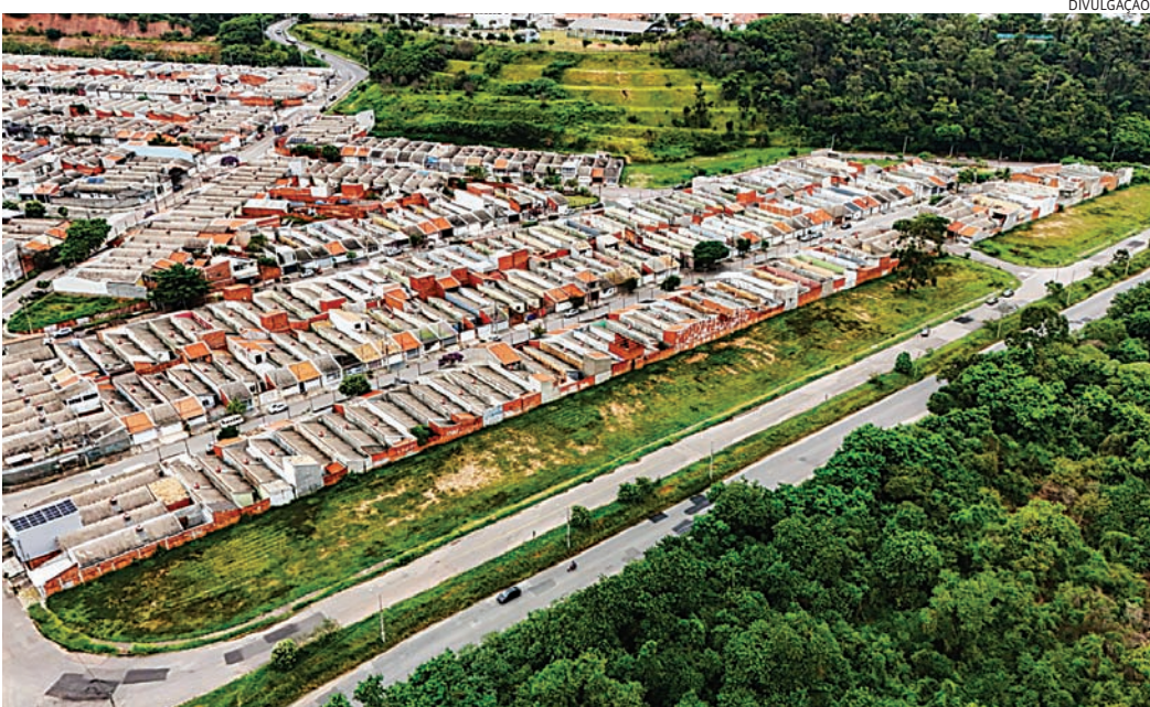
Residencial dos Cravos tem obras em andamento e previsão de entrega em 11 meses
