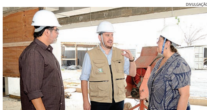
João Paulo faz visita técnica na obra do novo hospital
