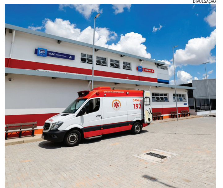
Prédio que abrigará o SAMU e o SAEC terá 765 metros quadrados
