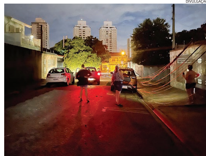
Fiação elétrica em derrubada após muita chuva e ventania
