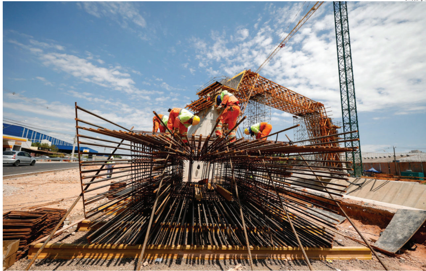
Em obra na avenida Ozanam, Jundiaí contará com uma ponte estaiada
