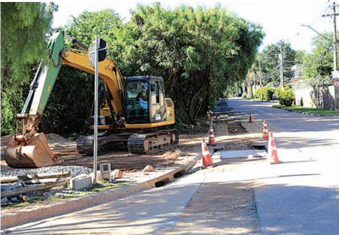
Malota: obra contempla 1,8 km de tubulação com diâmetro de 300 mm
