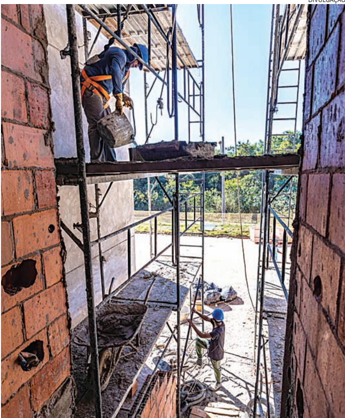
As próximas etapas incluem o início dos revestimentos internos
