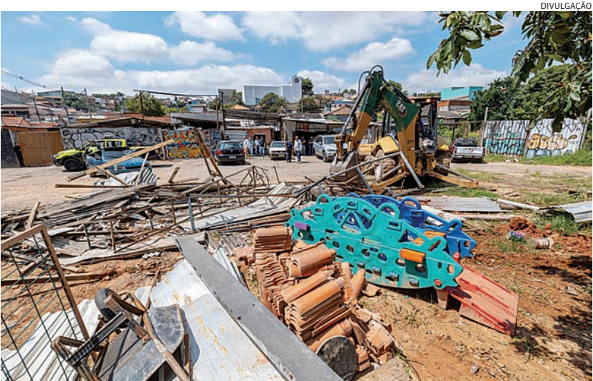
Moradias irregulares foram retiradas e os entulhos recolhidos do local
