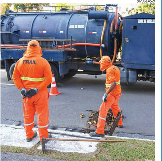
Além da limpeza há hidrojateamento para desobstrução das bocas
