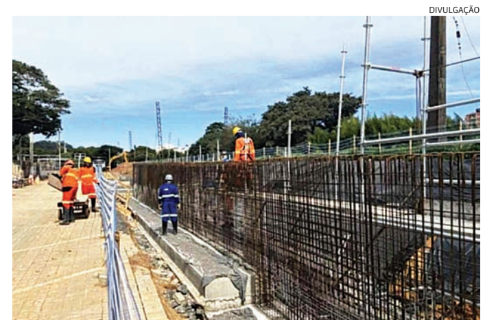
Durante a semana foi iniciada a concretagem do muro de contenção
