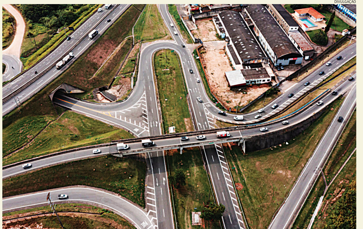
O viaduto garante a ligação entre a rodovia João Cereser e a avenida Humberto Cereser
