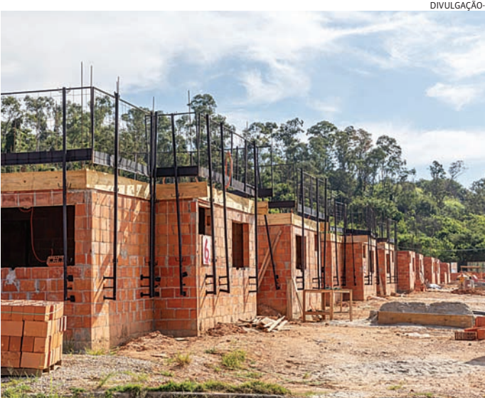
O Jd. dos Cravos já tem 49% de obra finalizada
