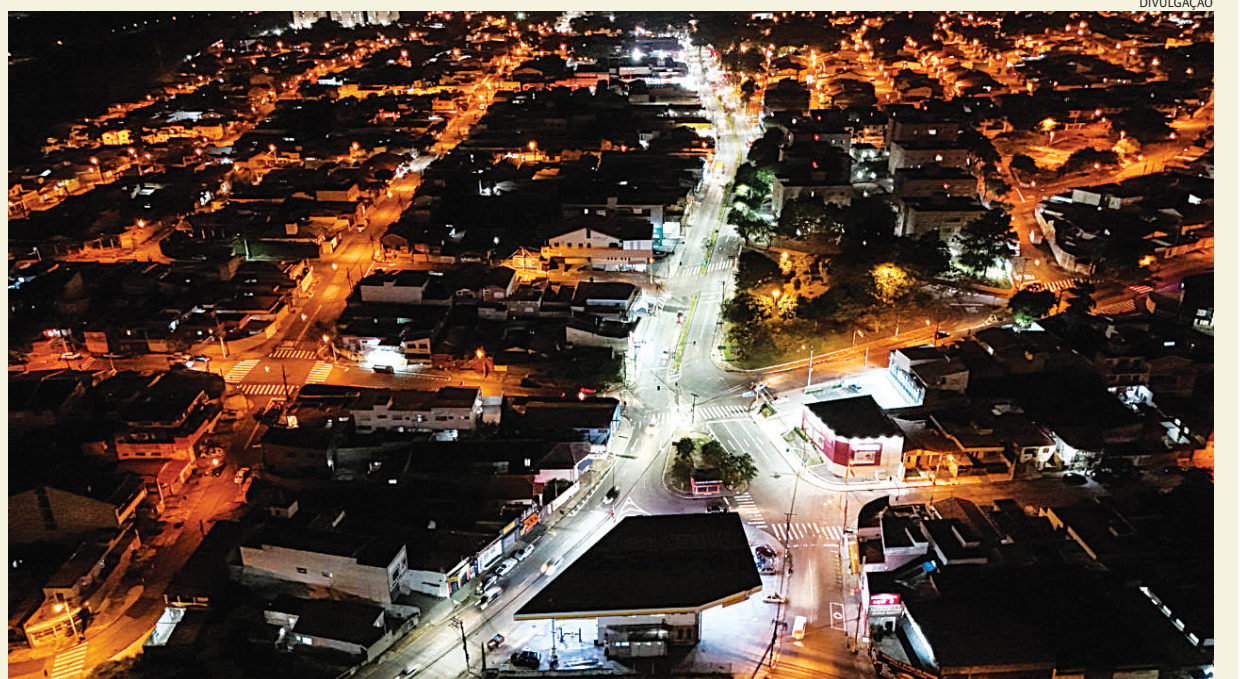
Instalações foram finalizadas na Região Sul, com 360 novos pontos
