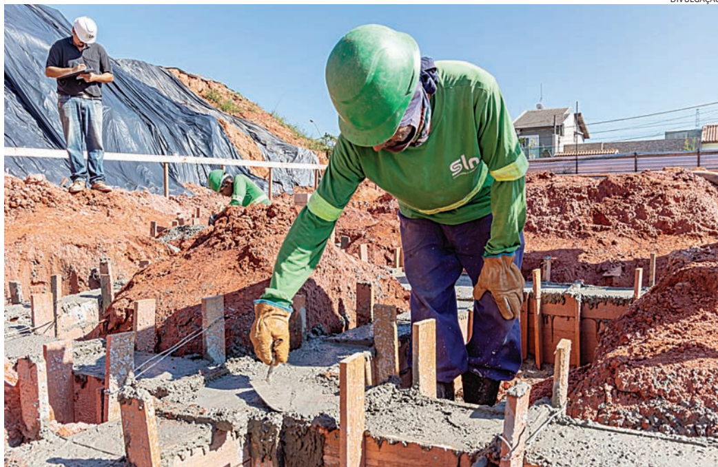
O novo prédio, com 1.541,14 m², vai qualificar a estrutura da unidade
