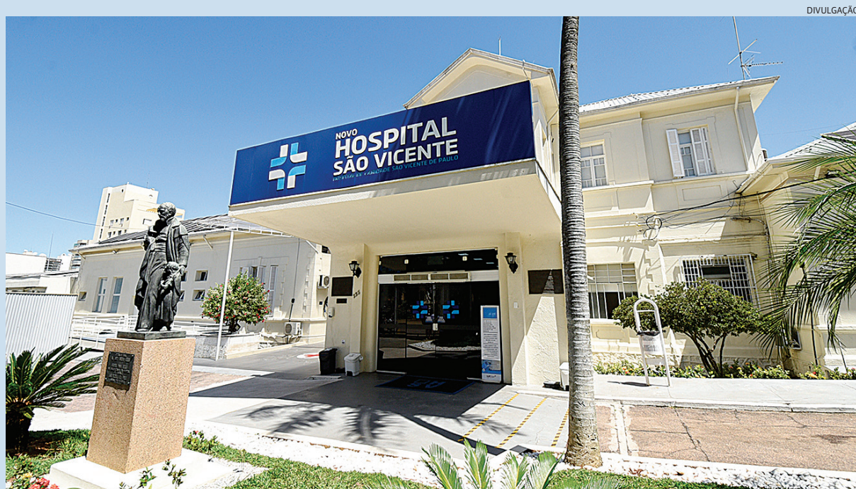
Hospital investe em infraestrutura, descentralização e gestão para aumentar nº de internações e cirurgias
