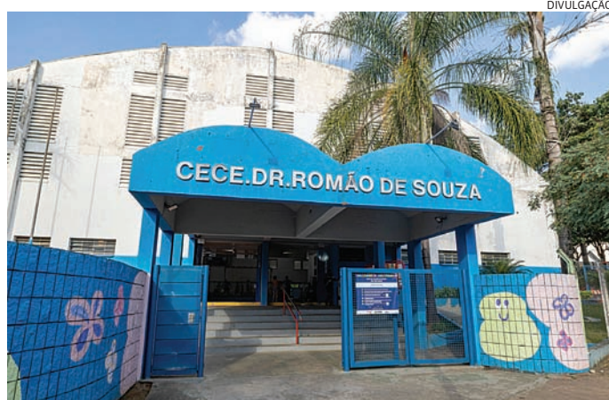
As obras incluem desde serviços de fundação até alvenaria
