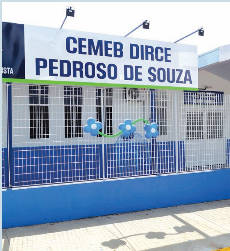
CEMEB Dirce Pedroso foi totalmente reformada e modernizada
