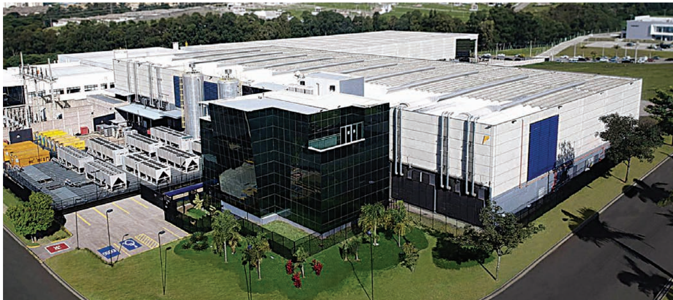
A Ascenty possui dois campi em Jundiaí e investe na Região
