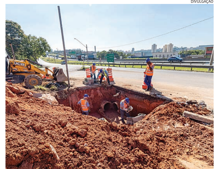
Também está prevista a readequação e ampliação das galerias
